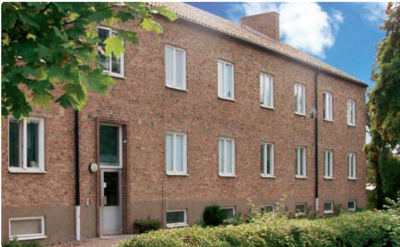
Huset på Parkgatan 10 genomgår en omfattande renovering. På vindsvåningen har det byggts ytterligare fyra lägenheter och fyra av de befintliga lägenheterna har renoverats till samma standard som de nyproducerade.
