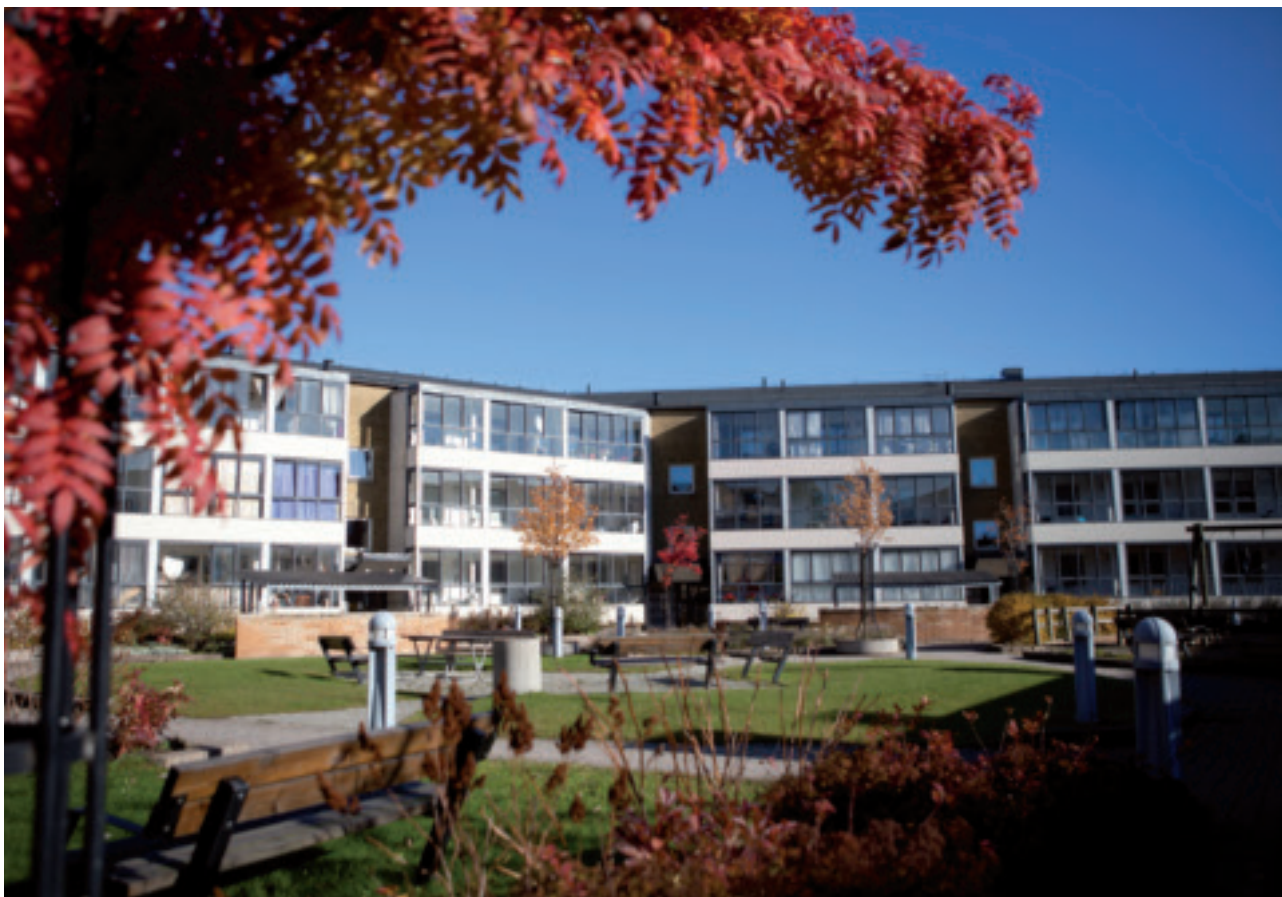
Kvarteret Hackspetten på Betlehemsgatan i Arlöv.
