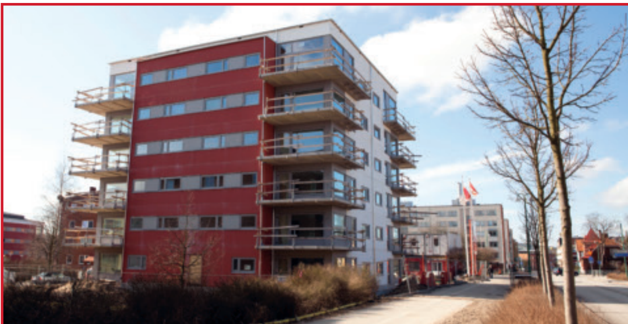
Under 2010 påbörjades byggnationen av 24 nya lägenheter i kvarteret Ripan mitt i centrala Arlöv. Inflyttning sker den 1 juni 2011.
