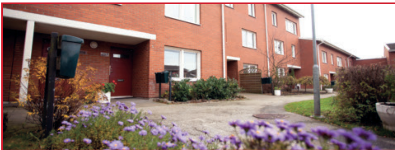
Under 2010 påbörjades ombyggnaden av Rinnebäcksområdet i Arlov.
