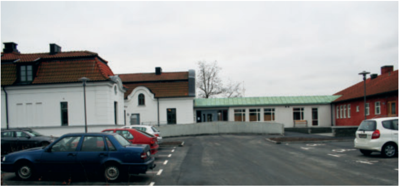
Det gamla ålderdomshemmet i Granliden har byggts om till nio bostäder för målgruppen 55+ och tio bostäder för LSS-boende. Inflyttning skedde i november 2008.
