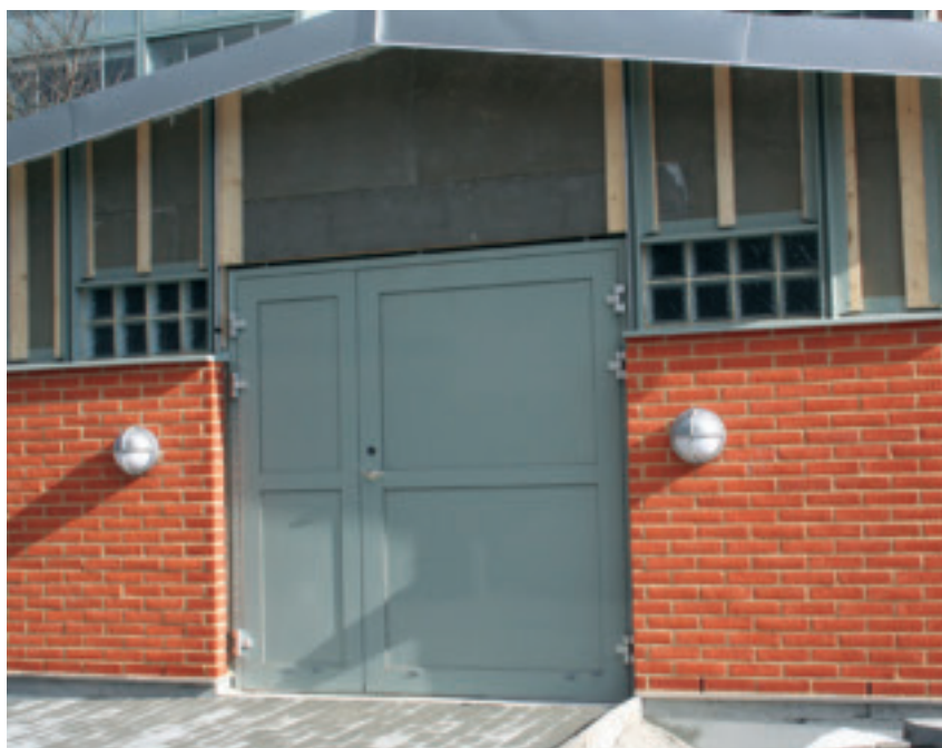
I samband med ombyggnaden av Svalan tas soprummen bort och miljöhus för fastighetsnära källsortering byggs.
