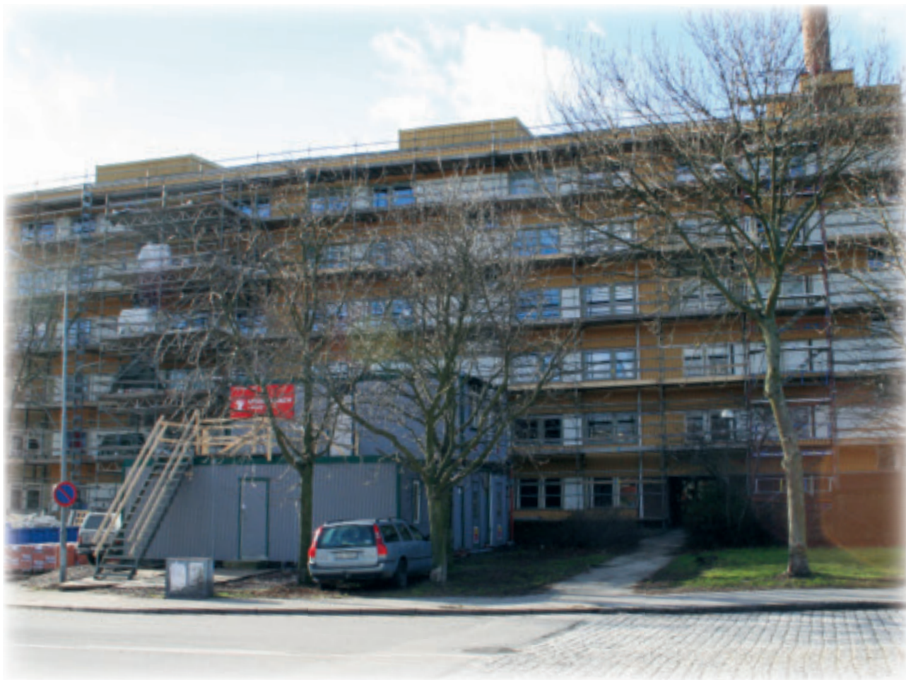
Ombyggnaden av Svalan beräknas pågå fram till augusti 2008.
